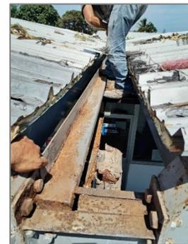
*Ilustración 73 - Rehabilitación del canalón*
